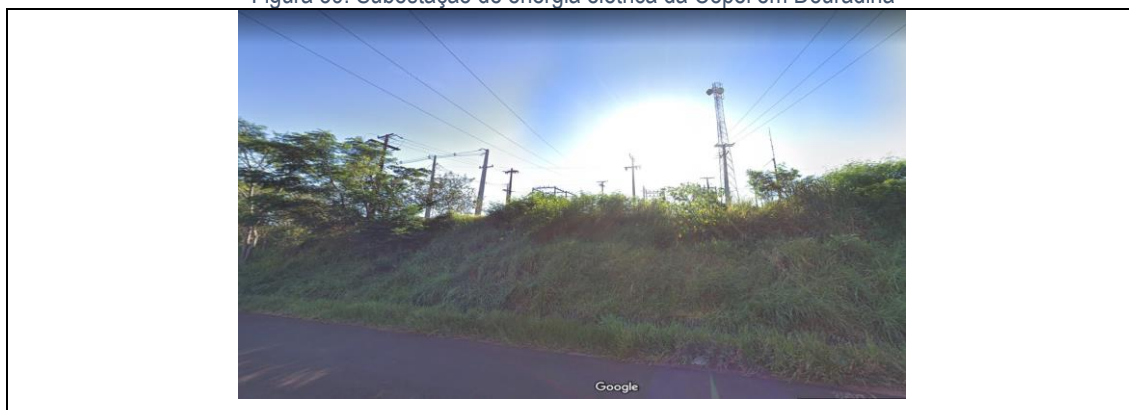
Figura 39: Subestação de energia elétrica da Copel em Douradina
