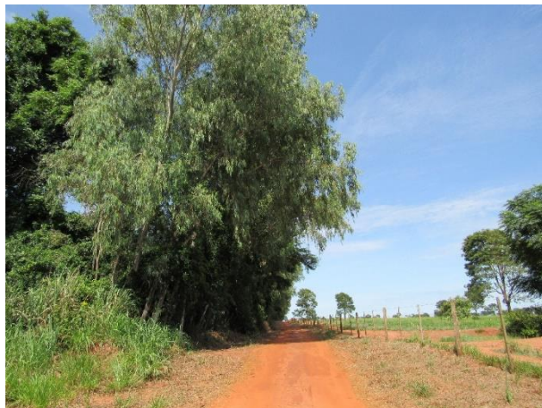
Figura 3-28: Visão geral da estrada de acesso (A.S-01).
